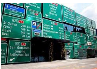
Nouvelle halle au Musée suisse des transports
